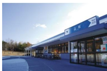
上板サービスエリア下り線
