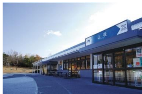
上板サービスエリア下り線
