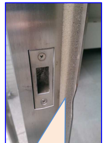
屋外扉の隙間にテープを貼り、外気を遮断しています。
