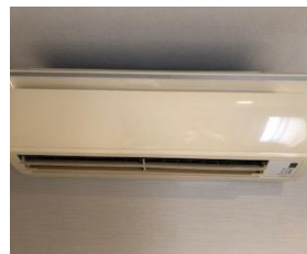
フィルター清掃後エアコン
