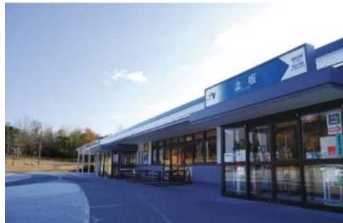
上板サービスエリア下り線
