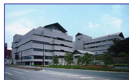
アルファあなぶきホール 外観
