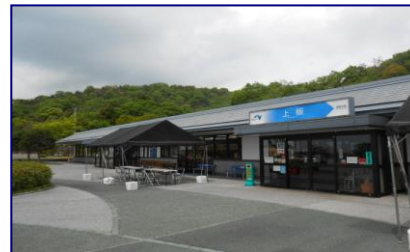
上板サービスエリア 外観
