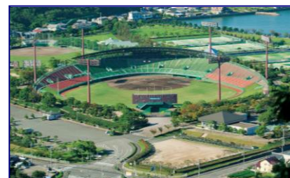
香川県総合運動公園 外観
