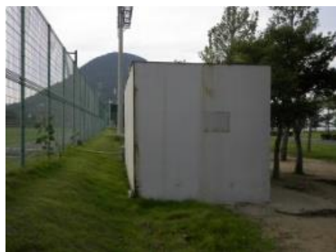
井戸水での植栽管理
